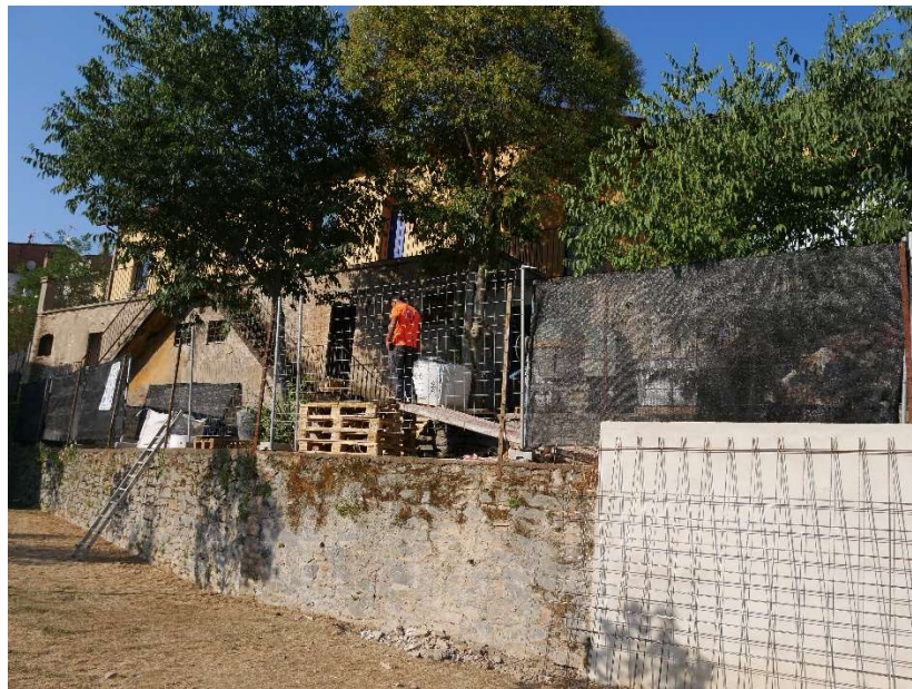
Imatge de l'inici de les obres
