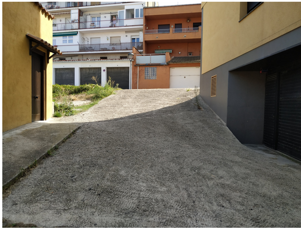
Tram superior del passatge d'Asdrúbal amb formigó abocat per accedir al pàrquing.
