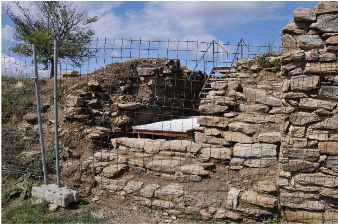
Detall del sector d'accés al part superior de la muralla, al costat de la torre ibèrica 1. Juliol 2014 i agost 2019
