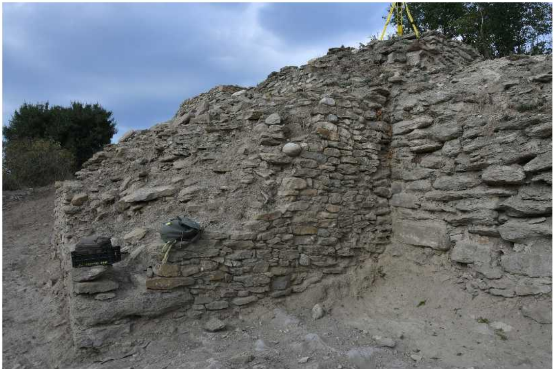
La torre carolíngia de la poterna. Agost 2019
