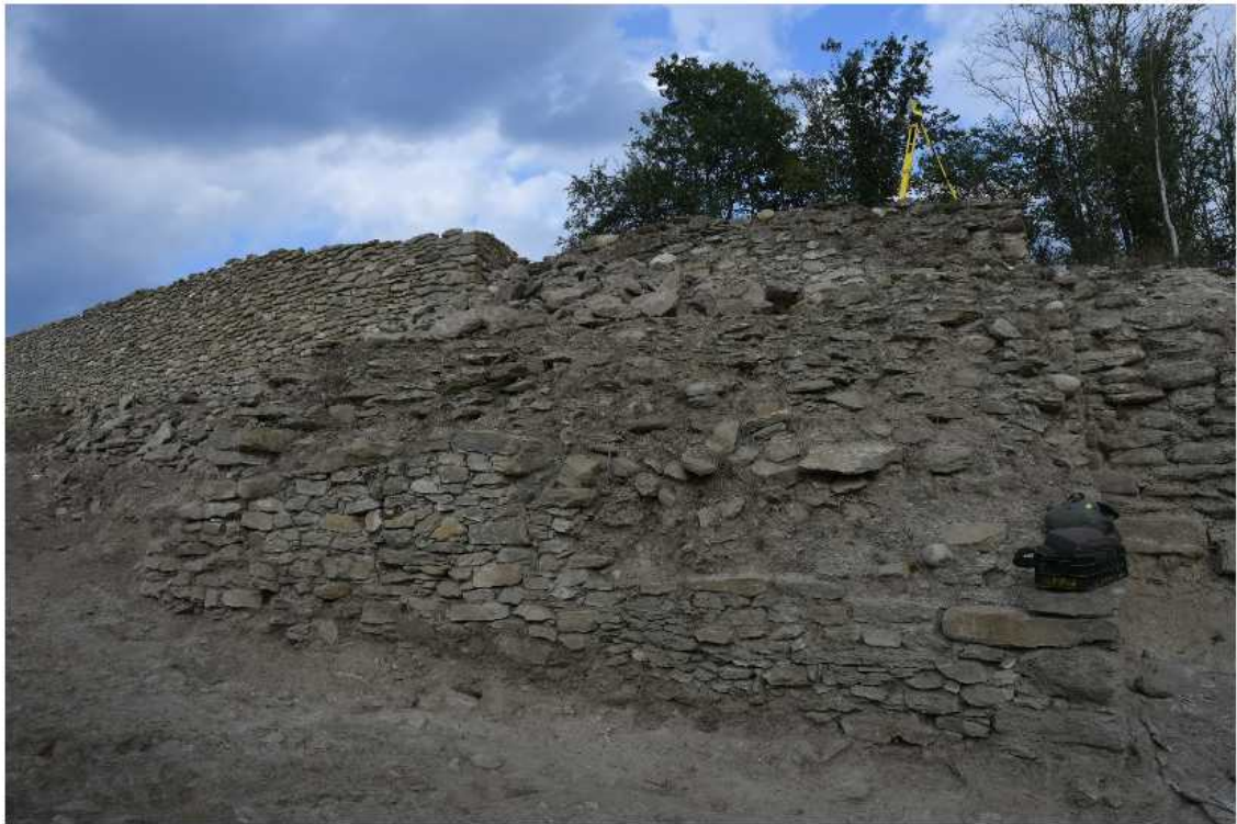
La torre de la poterna, al límit de la muralla consolidada el 2016. Agost 2019
